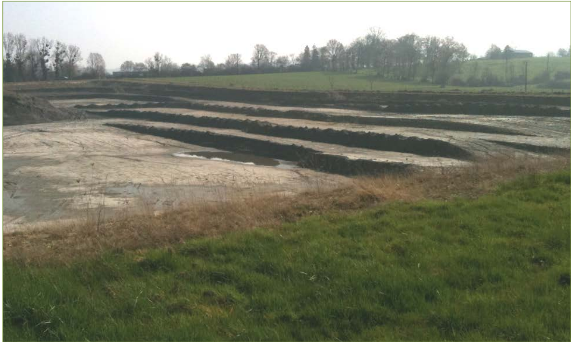
Vue d'un front de taille recoupé en gradins de 2 m en cours d'exploitation
